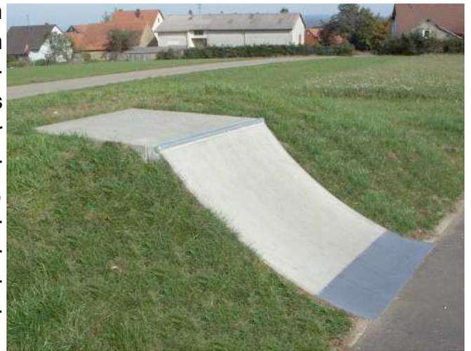
Skateelemente können im Erdreich auch auf ein verdichtetes (tragfähig min. 80kN/qm) und frostsicheres Kiesbett, in dem unter den Füßen Betonplatten (40 x 40 x 5 cm) eingelassen sind, aufgestellt werden. Die Rückseite der Elemente wird wie vorab beschrieben geschlossen.
